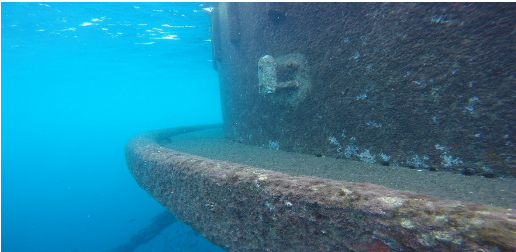
Figura. Fender submarino de la estructura de la Monoboya
