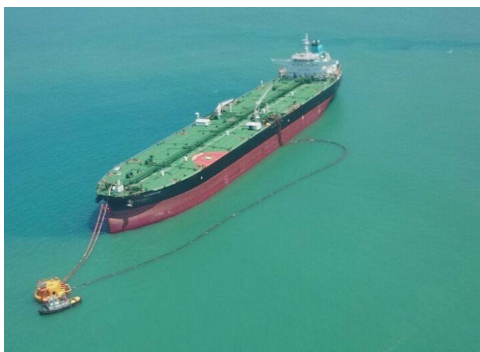
Imagen No. 3 Infraestructura Costa Afuera – Monoboya TLU1 en atención de buque tanque
